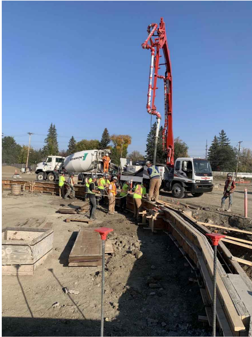
9/21/2023 – Northeast Grade Beam Pour
